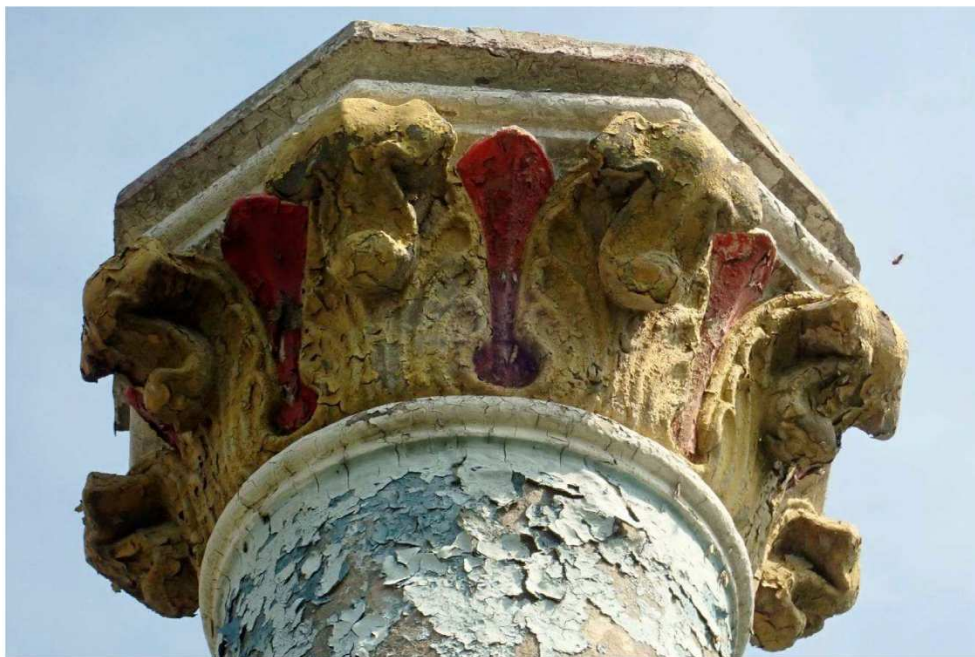
Fot. nr 30. Stan zachowania kapitelu. Widoczne spękania i deformacje abakusa.
