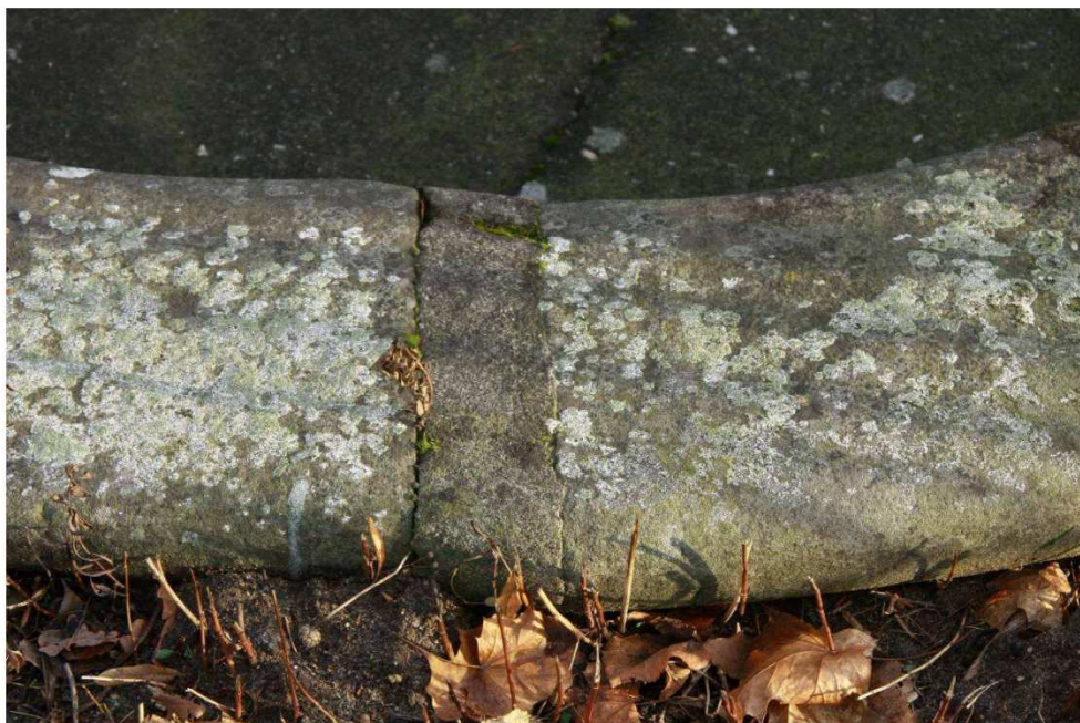
Fot. nr 43. Wtórne wypełnienia zdeformowanych spoin w elementach niecki.
