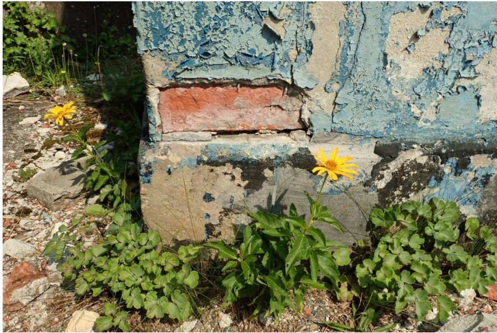
Fot. nr 40. Odspojenia wyprawy na podstawie obiektu odsłaniające ceglany trzon z czytelnymi objawami krystalizacji soli.
