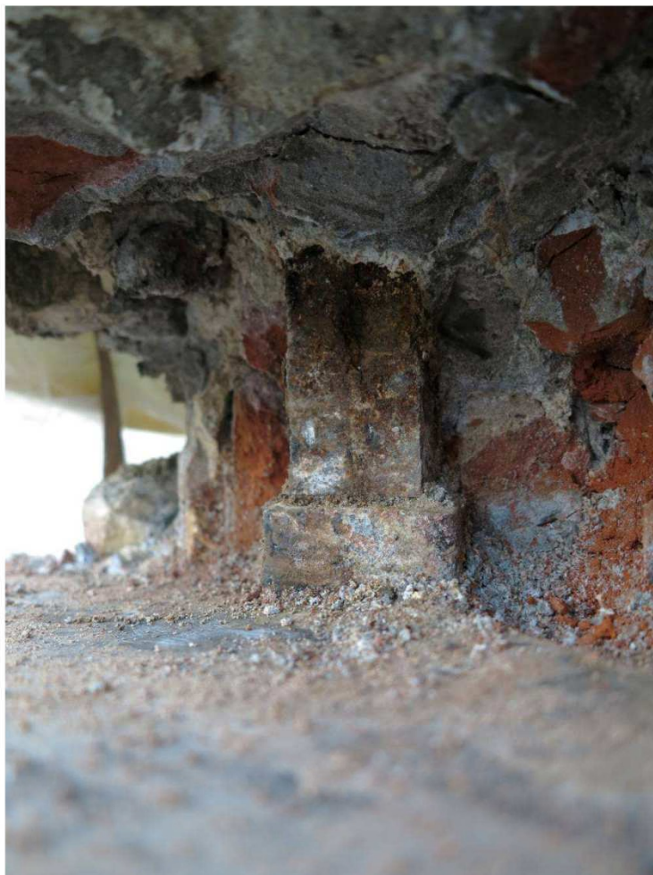
Fot. nr 19. Figura podczas demontażu w roku 2016. Widoczny korodujący trzczeń stalowy z obmurowaniem ceglany.
