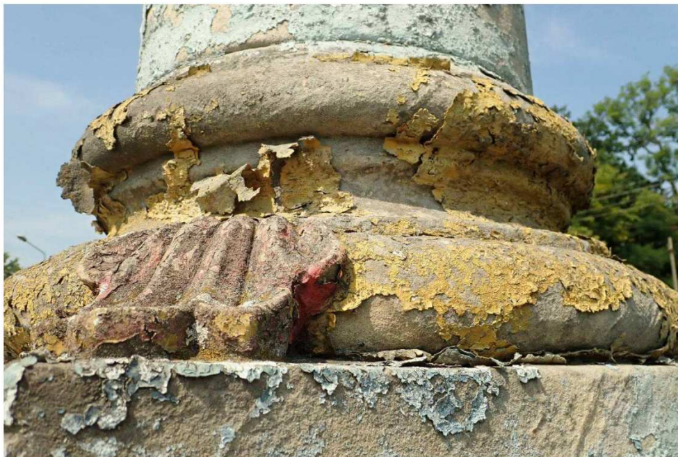
Fot. nr 34. Stan zachowania bazy kolumny właściwej. Widoczne łuszczące się przemalowania, odsłaniające zdeintegrowaną powierzchnię kamienia.
