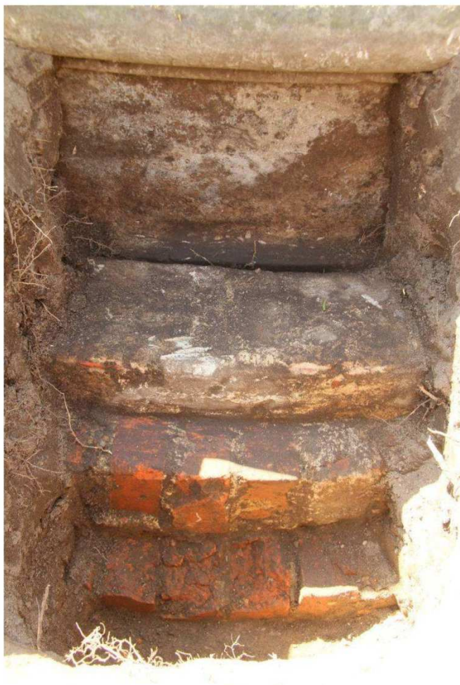
Fot. nr 46. Odkrywka pograżonej w gruncie kamiennej czaszy oraz schodkowo murowanych obramowania i fundamentów obiektu.
