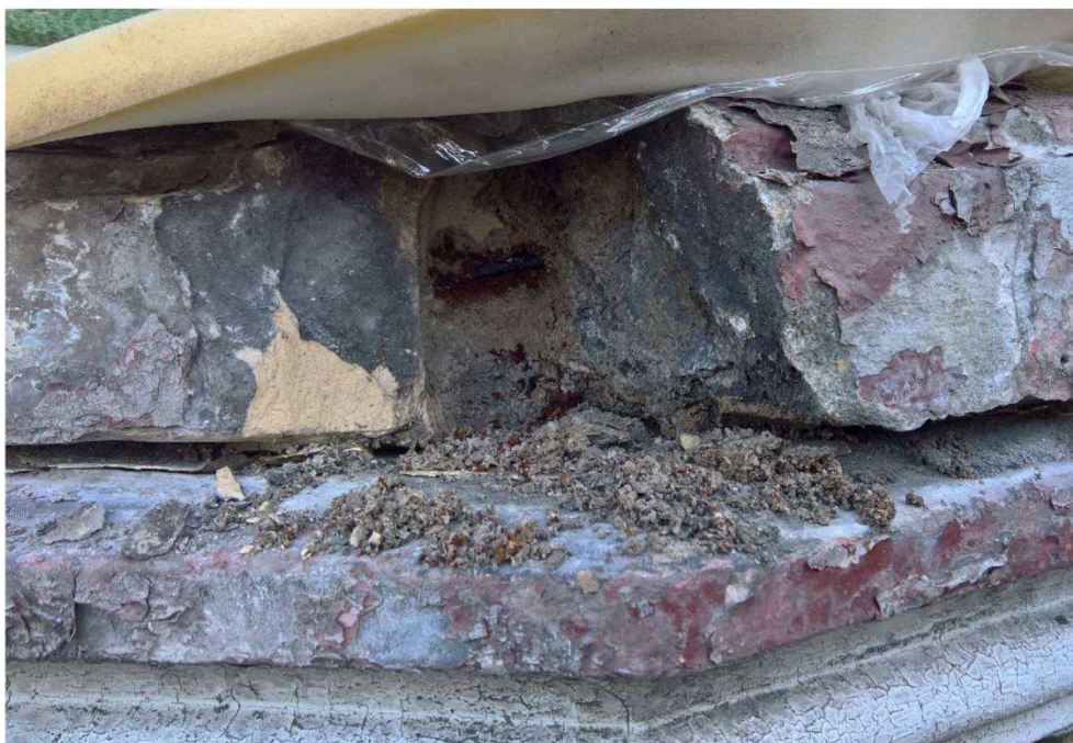
Fot. nr 18. Baza figury. Stan podczas demontażu w roku 2016. Czytelne korodujące zbrojenie uzupełnień ubytków oraz mokre, zdeintegrowane zaprawy.
