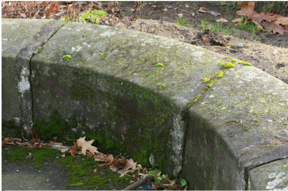
Fot. nr 42. Objawy korozji mikrobiologicznej na powierzchni zawilgoconego kamienia - zasiedlanie mchem i porostami.
