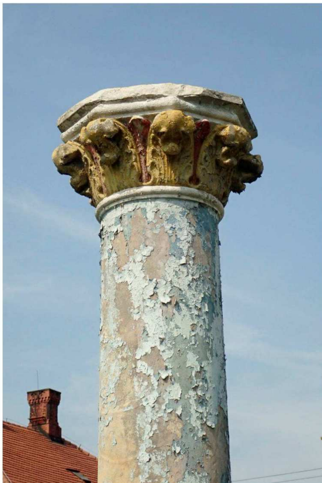
Fot. nr 29. Stan zachowania górnej części kolumny właściwej. Widoczne nawarstwienia na powierzchni kamienia oraz ubytki formy.
