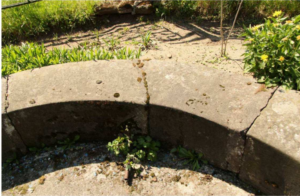
Fot. nr 41. Spękania i deformacje obramowania niecki. Widoczne kumulacje zasolenia i krystalizacji wodorowęglanu wapnia w strefach spękań kamienia.
