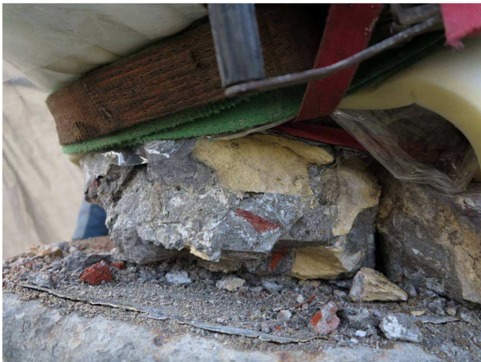
Fot. nr 16. Baza figury. Stan podczas demontażu w roku 2016. Widoczne historyczne zniszczenia uzupełnione betonem i cegłą.
