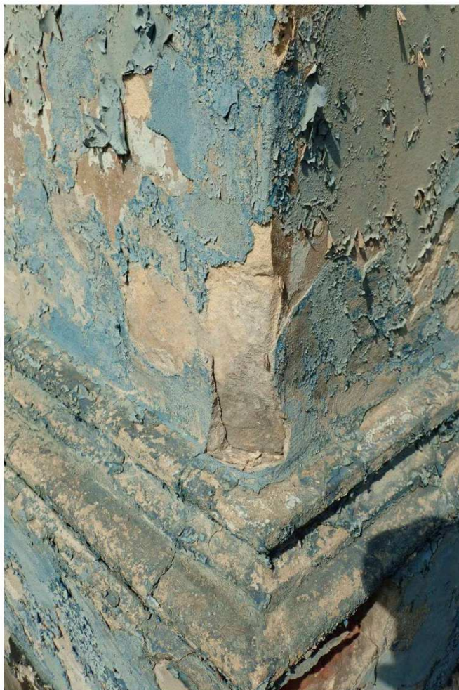
Fot. nr 36. Naroże postumentu. Widoczne spękania i duży ubytek kamienia.
