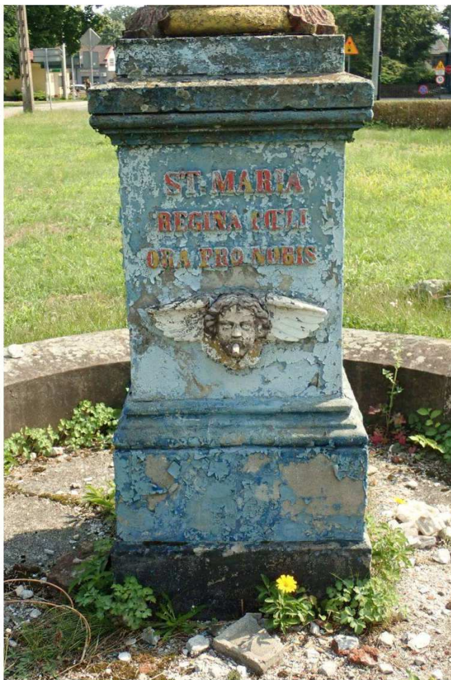
Fot. nr 31. Podstawa kolumny posadowiona w niecce fontanny. Stan zachowania. Widoczne spęcherzone i łuszczące wielokrotne przemalowania powierzchni.
