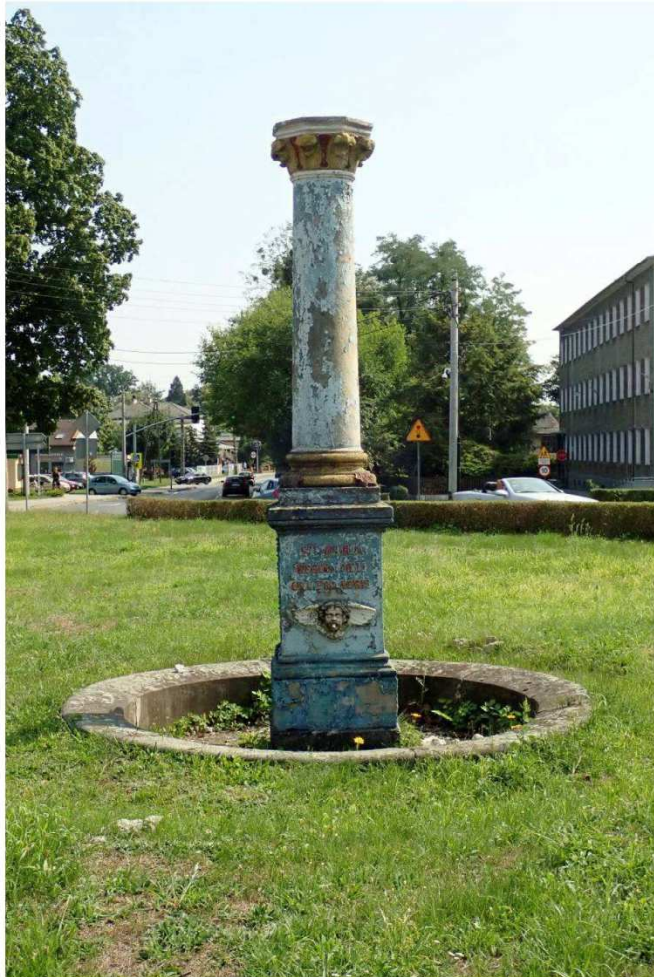
Fot. nr 27. Stan zachowania niecki i kolumny. Widok od strony północnej. Czytelne nadsypanie powierzchni gruntu i pograżenie niecki.
