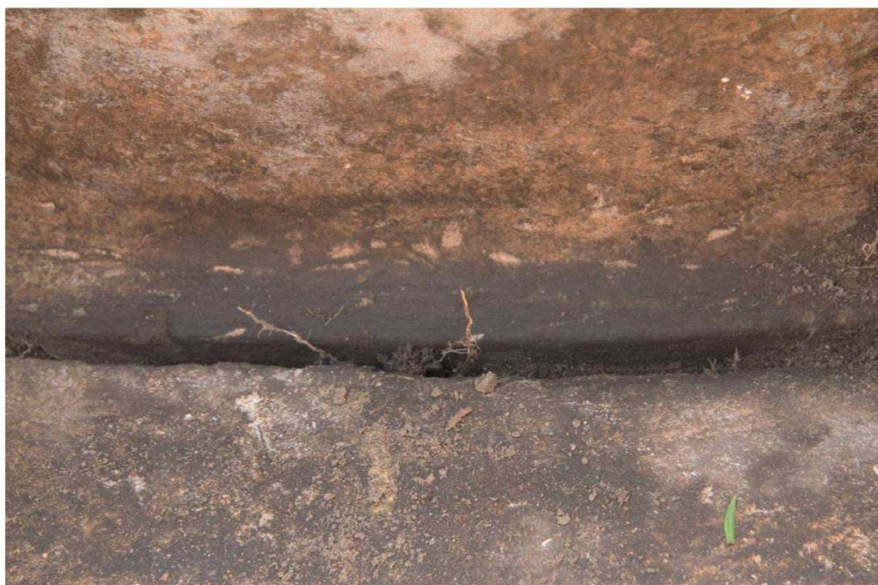
Fot. nr 47. Wyprofilowana podstawa zewnętrznej części niecki.
